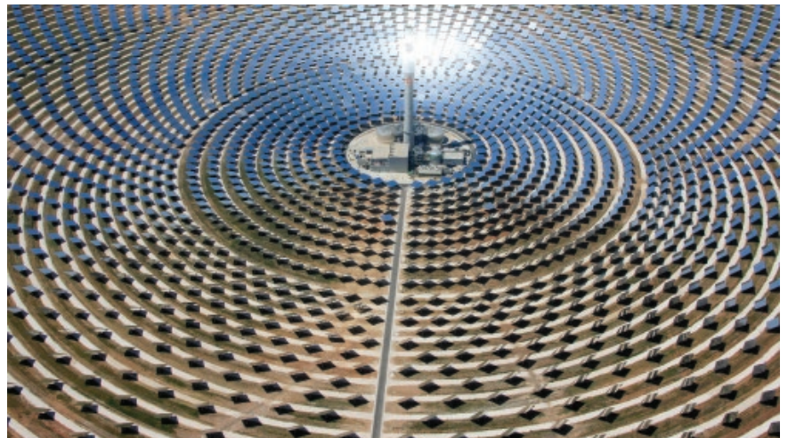
Fotoğraf 4: Aynalı türbin sistemi kullanarak Güneş enerjisinden elektrik üreten Rotem Industrial Park Elektrik üretim istasyonu.
